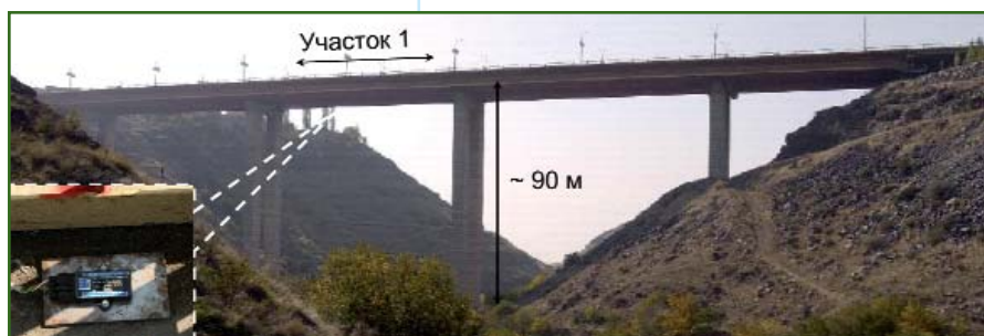
Рис. 5 Давидашенский мост в Ереване с обозначенным участком измерений
